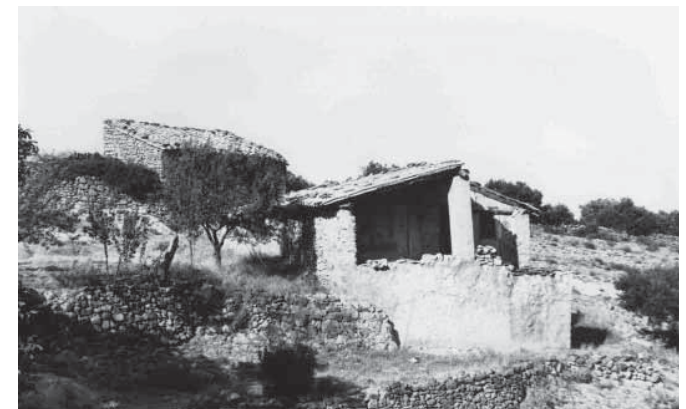
MAS DOLÇ Abans de la rehabilitació. Fotografia: fons Eixarch Frasno.
